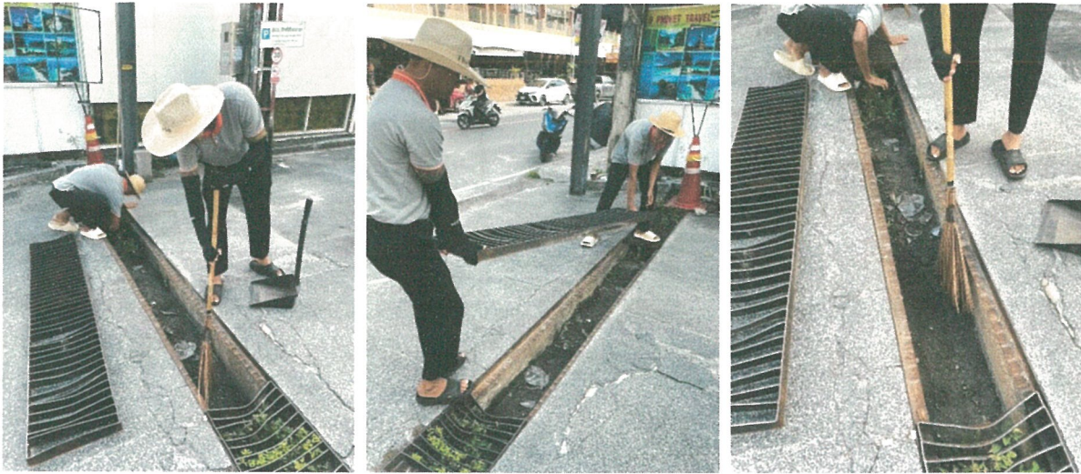
รูปภาพที่ 2.19 ขุดลอกตะกอน
